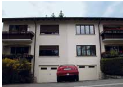
Kirlenme örneği: Aynı anda beyaz ile boyanan ve Lucerne'de yer alan özel bir konut. Solda: Silikon reçine boya Sağda: Silikat boya
