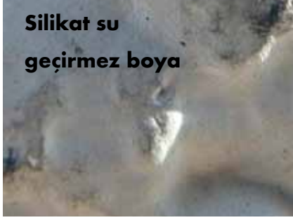
Figür 1 Silikon su geçirmez boya ve silikat boyalı dış duvar kaplaması, iki yıllık dış mekan hava koşullarının ardından
